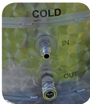
Snapkoblinger til kølevand og opvarmingsvand
